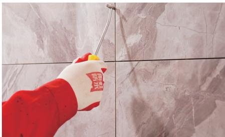
c. 使用毛刷或粉尘吸尘器将瓷砖缝隙内部的粉尘吸干净，保证瓷砖缝隙内无粉尘、浮灰、颗粒、油渍、疏松物等，同时清洁瓷砖表面污染物。
