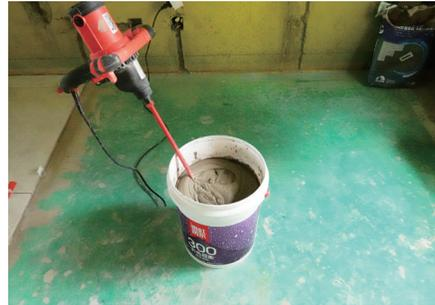
4、墙面批刮瓷砖胶。a. 面砖粘贴宜从房间角落开始，并粘贴两块至三块瓷砖，作为瓷砖完成面的标志块，用完成面的校正，作为整改基面面砖水平、垂直方向及铺贴厚度的依据，以确保其横平竖直。b. 用符合所需胶层厚度的齿型抹刀的直边将搅拌好的胶粘剂批到基面上，厚度小于 1mm 但务求全部满批，用于提高基面与胶粘剂的结合度。c. 用齿型抹刀的直边将胶粘剂按需求量厚度铺到批层上，上胶厚度应高于齿形抹刀的齿槽深度 2mm 及以上，批刮的面积不大于 1 平方米。d. 握住齿型抹刀与基面约成 60° 角，沿瓷砖缝方向将胶粘剂层梳理成均匀条状。
