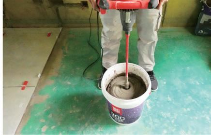
4、墙面批刮瓷砖胶：a. 将搅拌均匀的瓷砖胶用齿型抹刀的直面用力均匀的薄批一层至基层上面，厚度约为 1–2mm；b. 接着再厚批一层瓷砖胶，总厚度宜为 5–8mm；c. 最后使用齿形抹刀的齿面在批刮了瓷砖胶的墙面上，批刮出纹路(凹凸槽)，纹路饱满均匀，提高铺贴满粘率。注意要点：a. 刮刀面与墙面成 45–60° 角；b. 梳理纹路时，要有一定力度，保证抹刀齿面刮到墙面，梳理出的线条应高度一致，饱满均匀。
