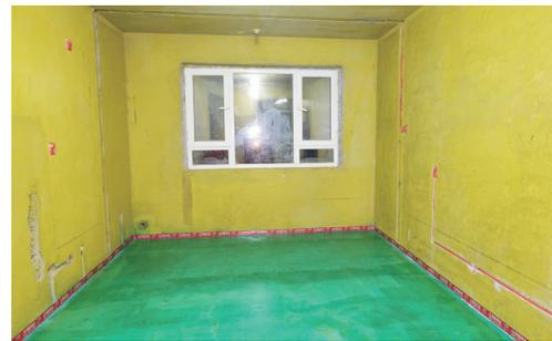
b. 烧结砖砌体：应先清除油污、表面杂物、残留灰浆、舌头灰、尘土，再浇水润湿基层，水应渗入墙体内10mm ~ 20mm。抹灰时，墙面不得有明水。
