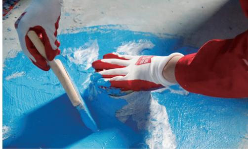
2、地漏附加层施工：a. 薄刷涂膜防水层的厚度为 0.3-0.5mm，涂膜应均匀不得有局部堆积现象；b. 铺贴胎体增强布的宽度宜为 200-300mm，平面搭接宽度为 150-250mm，地漏内返尺寸宜为 30-50mm 且胎体增强布不得有褶皱、不平、翘边现象；c. 涂膜覆盖胎体增强布时涂刷厚度为 0.3-0.5mm，保证涂膜涂刷均匀且不得露布。
