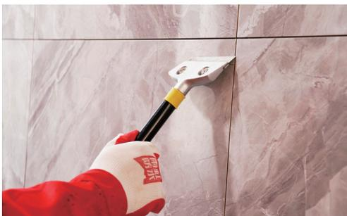
b. 用菱形清缝锥及清缝勾刀剔除缝隙内部浮灰、浮砂、颗粒、十字卡等污染物，保证缝隙深度。
