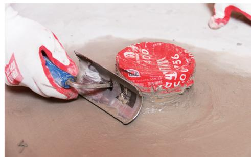
4、阴阳角的处理方法：a. 阴角宜采用 1: 3 水泥砂浆或防水堵漏宝抹成圆弧，抹弧直径为 40-50mm；b. 阳角应用磨光机打磨光滑且圆弧半径不小于 10mm，否则会因为应力集中发生开裂问题。
