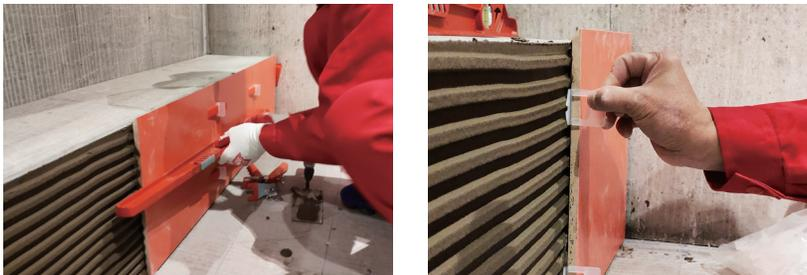
8、拆除调平器：24 小时后，使用橡皮锤沿瓷砖缝隙方向敲掉找平器底座，并回收找平器楔子。
