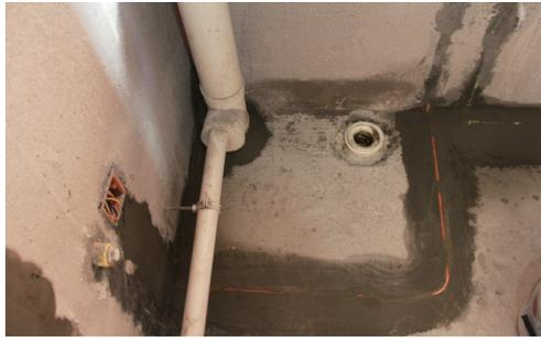
3、管根、地漏部位的处理方法：a. 管根、地漏周围应剔成深 10mm，宽 20mm 的凹槽，用密封胶并覆盖水泥砂浆密封处理或采用防水堵漏宝抹弧处理，抹弧直径为 40-50mm；b. 管道表面要进行打磨增糙或除锈处理；c. 美纹胶带粘贴管道的标高为 150mm。
