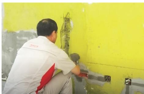
4、冲筋。a、检查灰饼硬化程度，确定其灰饼的硬化程度是否符合要求，当灰饼收水且硬化后，使用与抹灰层相同的找平砂浆进行冲筋处理；b. 在上、下两个灰饼之间抹出一条宽度为 8cm 左右的梯形灰带，厚度与灰饼的相同，作为基面找平抹灰的厚度标准。其做法是在上、下两灰饼中间先抹一层灰带，收水后再抹第二遍，
