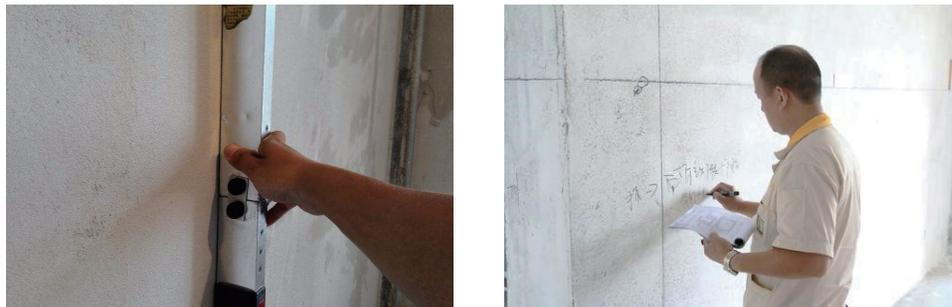
2、墙面安装锚固件，根据瓷砖安装位置，在墙面打孔植胶，埋入锚固件；
