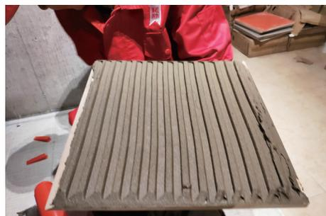
6、瓷砖铺贴：将准备好的陶瓷砖与墙体槽痕平行铺压到位，使其略高于标志块，并垂直于梳理方向轻微搓动以排出砖下的空气，使面砖紧密粘于墙面上。注意要点：a. 在粘接层允许调整的时间内（20~30min），可调整瓷砖的位置和接缝并压实，超过允许调整的时间后，严禁移动瓷砖；b. 一面墙不宜一次铺贴到顶，以防塌落，每次铺贴高度一米为宜；c. 瓷砖尺寸过大时，使用橡皮锤轻轻敲打或瓷砖振平器振平。
