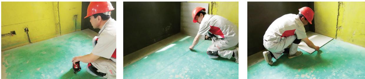
2、瓷砖切割。a. 根据瓷砖排版放样及弹线结果，对基面上插座开关的位置进行测量，确定其开孔位置；b. 根据测量结果，使用记号笔在所切割的瓷砖表面进行切割线标记；c. 选择直接为 6mm 或 10mm 的钻头，沿着标记的切割线进行开孔，打孔力度要均匀，并且打孔同时进行喷水降温处理，避免瓷砖开裂（开孔钻头应与横竖切割线相切）；d. 开孔完毕后，使用切割机沿着标记线进行切割，直至瓷砖切割面断开。
