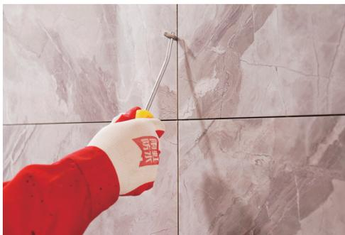
c. 使用毛刷或粉尘吸尘器将瓷砖缝隙内部的粉尘吸干净，保证瓷砖缝隙内无粉尘、浮灰、颗粒、油渍、疏松物等，同时清洁瓷砖表面污染物。
