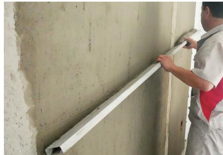
防水防潮 4 步：主要包括防水防潮部位确定、节点处理、附加层施工、防水防潮大面施工。第一步：确定防水防潮施工部位。常见的防水部位有卫生间墙地面、厨房墙地面、阳台地面、地暖部位；常见的防潮部位有卫生间背水面一侧墙体、外墙内侧、地下室。在进行防水防潮施工时，需要针对不同的施工部位选择不同类型的防水防潮产品。例如，卫生间、厨房、阳台等迎水面的防水材料应选择偏柔性的防水涂料，具有更高的防水抗渗性能；地下室、内墙等背水面部位则需要选择刚性的防水浆料，能够更好的阻止潮气的渗入。而类似于地暖这类特殊部位，需要兼顾地暖可能导致的漏水问题以及地暖上部渗水对地暖的破坏问题，因此地暖部位需要在上下两侧进行防水施工。地暖属于高温、易变形部位，还需要选用耐高温、柔性的防水涂料。
