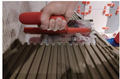
5、瓷砖背面批刮瓷砖胶：a. 将搅拌均匀的瓷砖胶用齿型抹刀的直面用力均匀的薄批一层至瓷砖背面，厚度约为 1-2mm；b. 接着再厚批一层瓷砖胶，总厚度宜为 5—8mm；c. 最后使用齿形抹刀的齿面在批刮了瓷砖胶的瓷砖背面上，批刮出纹路（凹凸槽），纹路饱满均匀，提高铺贴满粘率。注意要点：a. 刮刀面与瓷砖背面成 45-60° 角；b. 批刮前需清理瓷砖背面灰尘及脱模剂，避免掉砖问题发生；c. 马赛克及尺寸 ≤ 150\*150 的瓷砖背面无需批刮瓷砖粘结剂。
