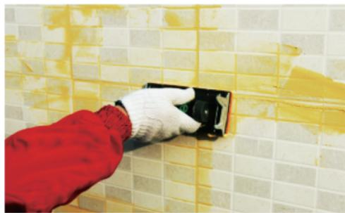
g. 检查缝隙中填缝剂的收水及硬化程度，及时用硬纤维海绵和清洁水擦掉瓷砖表面的美缝剂以及进行擦缝。
