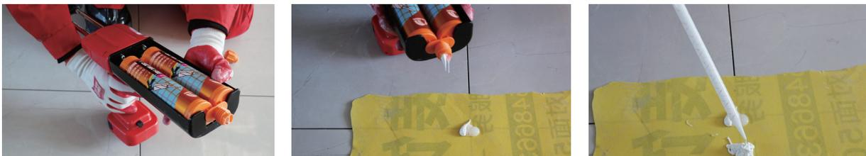
h. 施工时混合棒尽可能与瓷砖面呈 45° 角以便靓缝剂能充满缝隙，缓缓用力将料均匀涂在缝中，并掌握好力度和频率，均匀的向后移动混合管，保证瓷砖缝隙填充均匀饱满。
