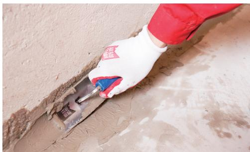
第三步：附加层的施工。1、管根处附加层施工：a. 薄刷防水层的厚度为 0.3-0.5mm，涂膜应均匀不得有局部堆积现象；b. 铺贴胎体增强布，宽度宜为 200-300mm，平面搭接宽度为 150-250mm，管道搭接高度为 50mm 且胎体增强布不得有褶皱、不平、翘边现象；c. 涂膜覆盖胎体增强布时涂刷厚度为 0.3-0.5mm，保证涂膜涂刷均匀且不得露布。
