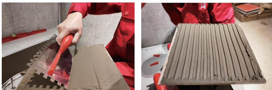
7、瓷砖铺贴：将准备好的陶瓷砖与墙体槽痕平行铺压到位，使其略高于标志块，并垂直于梳理方向轻微搓动以排出砖下的空气，使面砖紧密粘于墙面上。注意要点：a. 在粘接层允许调整的时间内（20~30min），可调整瓷砖的位置和接缝并压实，超过允许调整的时间后，严禁移动瓷砖；b. 一面墙不宜一次铺贴到顶，以防塌落，每次铺贴高度一米为宜；c. 瓷砖尺寸过大时，使用橡皮锤轻轻敲打或瓷砖振平器振平。
