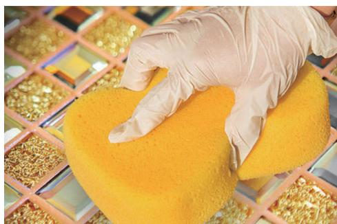
h. 清理好的陶瓷砖面应该立即摆放标识进行隔离，避免污染或扰动，直至美缝剂充分凝固和硬化后能够承受载荷。
