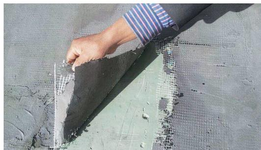
d. 混凝土 / 光滑防水基层：对其它种类（如混凝土、柔性防水涂层）的墙体，均应采用加固剂兑水泥对基面进行拉毛，以提高抹灰砂浆与基面的粘结。
