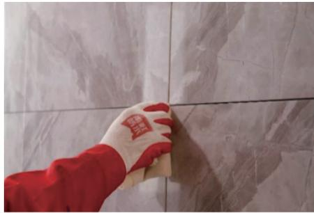
e. 表面粗糙的瓷砖，需要在缝隙边缘打蜡或粘贴美纹纸做保护。打蜡采用两侧擦蜡的方式，避免有蜡进入缝隙。美纹纸边缘与缝隙处于同一水平线且宽度不小于 2cm。
