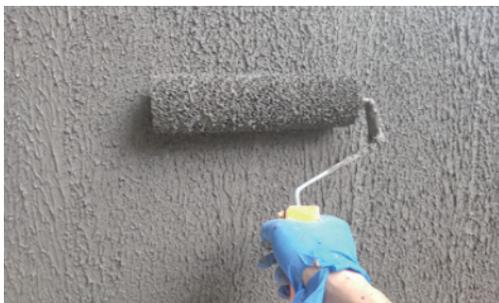
3、拉毛效果检查：待拉毛层固化后（需 12 小时），方可进行后续找平。注意：检查拉毛层是否出现了开裂、起粉、强度低、毛刺发软等问题。若出现，则需要将拉毛层铲除，再重新拉毛施工。
