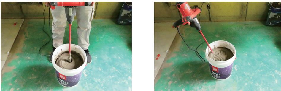
5、墙面批刮瓷砖胶。a. 面砖粘贴宜从房间角落开始，并粘贴两块至三块瓷砖，作为瓷砖完成面的标志块，
