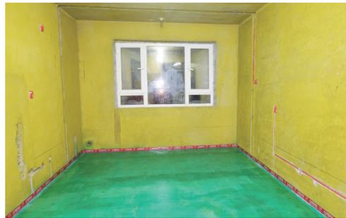
第二法：基层拉毛。主要针对光滑的基层，例如光滑的防水层、铝模浇筑的混凝土等。其作用是增强抹灰砂浆与基层的粘接。采用的拉毛材料是由加固剂、水泥按照一定比例混合而成的浆料（加固剂建议选择雨虹 J100 强效型加固剂、雨虹 J101 彩色全效型加固剂、J102 彩色防潮型加固剂，水泥建议使用 P.O42.5 普通硅酸盐水泥）。施工方式是：1、使用打磨工具对混凝土基面的脱模剂进行打磨处理，清理完脱模剂之后再行拉毛处理。柔性防水层基面无需打磨处理。
