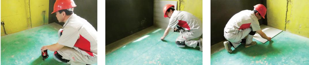
3、瓷砖切割。a. 根据瓷砖排版放样及弹线结果，对基面上插座开关的位置进行测量，确定其开孔位置；b. 根据测量结果，使用记号笔在所切割的瓷砖表面进行切割线标记；c. 选择直接为 6mm 或 10mm 的钻头，沿着标记的切割线进行开孔，打孔力度要均匀，并且打孔同时进行喷水降温处理，避免瓷砖开裂（开孔钻头应与横竖切割线相切）；d. 开孔完毕后，使用切割机沿着标记线进行切割，直至瓷砖切割面断开。
