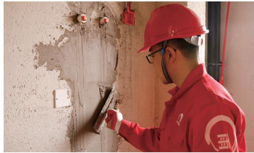
为了确保抹灰砂浆与基层牢固地结合，防止抹灰层空鼓起壳，抹灰前必须对基层表面进行界面处理，提高与找平层的粘结性。以下是常见的几种不同类型的基层找平找方前的处理方式：a. 对于普通砂浆层基面，直接采用加固剂进行套胶加固处理。
