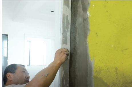
5、大面抹灰要求：冲筋 2h 后，待砂浆达到一定程度后，先抹一层薄灰，并应压实、覆盖整个基层，待前一层六七成干时，再分层抹灰、找平。抹灰砂浆应分层铺设，每遍厚度宜为 5 ~ 7 mm。当抹灰总厚度超出 35 mm 时，应在抹灰层间加铺防锈钢筋网或耐碱玻纤网增强。加铺的钢筋网一般需要用机械的方法将其锚固在基面上。后续的抹灰层应待前一层充分凝结后再施用。砂浆铺设完成后 12 小时，应开始洒水养护的工作，并在整个养护期内一直保持砂浆层的表面润湿状况。抹灰砂浆层的养护期越长越好。
