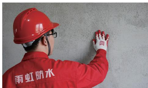
2、基层处理：a. 基层空鼓处理，使用电锤将空鼓部位敲掉，再使用修补砂浆对空鼓部位进行修补抹平；b. 基层起灰起砂处理，使用扫铲刀将基层的浮灰浮砂及污染物清理干净，提升基层加固效果（加固剂一般渗透深度为 2~3mm，浮灰太厚，加固剂无法不能充分渗透）。
