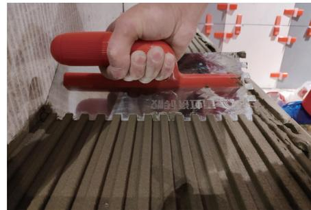
5、瓷砖背面批刮瓷砖胶：a. 将搅拌均匀的瓷砖胶用齿型抹刀的直面用力均匀的薄批一层至瓷砖背面，厚度约为 1–2mm；b. 接着再厚批一层瓷砖胶，总厚度宜为 5–8mm；c. 最后使用齿形抹刀的齿面在批刮了瓷砖胶的瓷砖背面，批刮出纹路(凹凸槽)，纹路饱满均匀，提高铺贴满粘率。注意要点：a. 刮刀面与瓷砖背面成 45–60° 角；b. 批刮前需清理瓷砖背面灰尘及脱模剂，避免掉砖问题发生。
