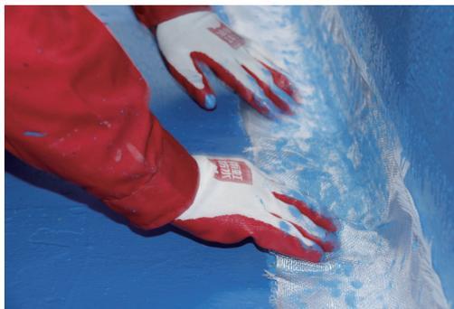
第四步：防水大面施工。大面施工时需均匀涂刷、先刷墙面后刷地面。第一遍施工后，确保底面不漏涂；第二遍涂刷应与第一遍涂刷方向呈垂直交叉，第三遍是涂刷方向与第二遍涂刷方向垂直交叉，保证防水涂料均匀遮盖基层。待立面最后一遍施工完成后，撕掉美纹胶带，并进行修边。地面涂刷时，薄涂即可，避免地面积料，导致防水涂料过厚开裂。
