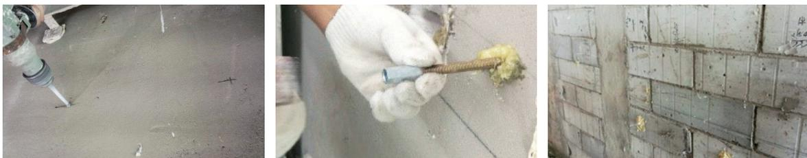
3、瓷砖背条的安装，a. 将瓷砖粘贴处的脱模剂打磨干净，防止粘接不牢，导致脱落；b. 将瓷砖背条上的脱模剂打磨干净，并使用 AB 干挂胶进行粘接；c. 待瓷砖背条粘接牢固后，在挂件点位开一小槽，以便 T 型骑缝片的埋入；
