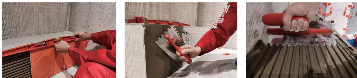
6、瓷砖背面批刮瓷砖胶：a. 将搅拌均匀的瓷砖胶用齿型抹刀的直面用力均匀的薄批一层至瓷砖背面，厚度约为1-2mm；b. 接着再厚批一层瓷砖胶，总厚度宜为5-8mm；c. 最后使用齿形抹刀的齿面在批刮了瓷砖胶的瓷砖背面上，批刮出纹路（凹凸槽），纹路饱满均匀，提高铺贴满粘率。注意要点：a. 刮刀面与瓷砖背面成45-60°角；b. 批刮前需清理瓷砖背面灰尘及脱模剂，避免掉砖问题发生；c. 马赛克及尺寸≤150\*150的瓷砖背面无需批刮瓷砖粘结剂。
