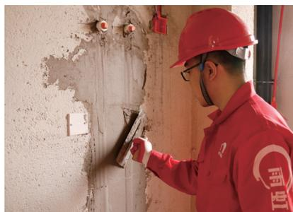
第四法：基层找平。是指当基层平整度、方正度不满足瓷砖铺贴的要求时，进行的找平找方工作。基层找平需要的材料是水泥砂浆外掺砂浆增强宝。砂浆增强宝的主要作用是提高砂浆的强度，改善砂浆和易性、降低泌水率，提高抗冻性和抗渗性能，克服空鼓、开裂等状况。施工步骤为：1、基层检查及处理：a. 采用空鼓锤检测基层是否有空鼓问题，若出现空鼓问题，需要凿除空鼓部位并使用修补砂浆进行修补；b. 将孔洞、箱、槽、盒周边杂物清除干净。再用修补砂浆把管线凹槽、线盒周边、管线周边、孔洞填补密实、平整、光滑，且修补找平用的砂浆应与抹灰砂浆一致。孔洞、箱、槽、盒外口应与抹灰面齐平或略低于抹灰面；c. 使用铲刀及扫把清理基层表面的杂物保证基层稳定、坚固、平整，基面不应该有浮尘、漆蜡、油脂、松散残留物等任何有可能
