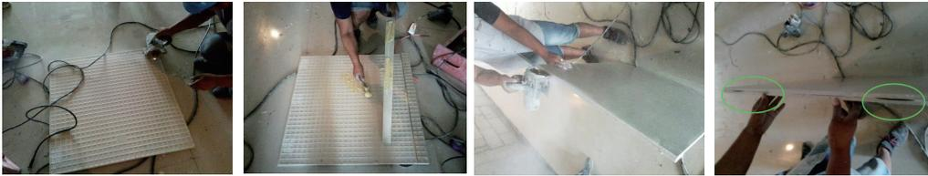
4、瓷砖干挂上墙：a. 在开槽部位涂抹 AB 干挂胶，用以固定 T 型骑缝片；b. 插入 T 型骑缝片，安装瓷砖，并拧动套筒，调节瓷砖面的平整度；c. 待 AB 干挂胶干固后，再次安装下一块瓷砖；安装瓷砖时，从下往上依次安装。
