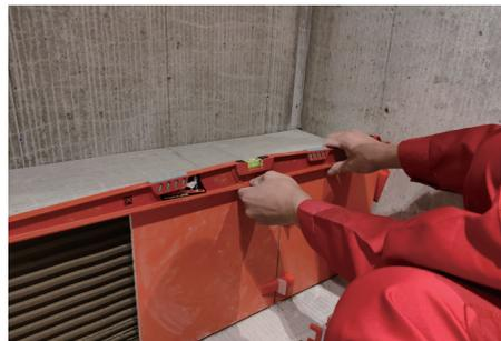
9、拆除调平器：24 小时后，使用橡皮锤沿瓷砖缝隙方向敲掉找平器底座，并回收找平器楔子。
