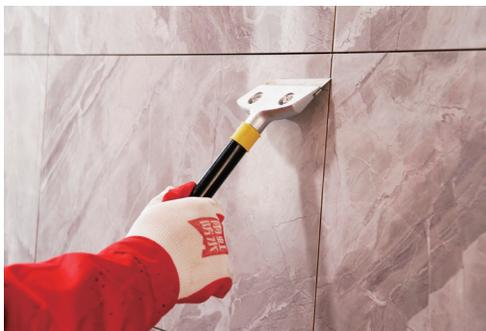
b. 用菱形清缝锥及清缝勾刀剔除缝隙内部浮灰、浮砂、颗粒、十字卡等污染物，保证缝隙深度。
