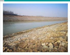
2022年5月24日,位于河南省信阳市息县的大别山革命老区引淮供水灌溉工程成功实现破堰进水。引淮供水工程护坡采用了天鼎丰聚丙烯长丝针刺土工布。其单纤强度高,整体物理力学指标高;旦数粗,孔径大,垂直渗透系数能达到0.25cm/s,等效孔径能达到0.15mm,具有良好的透水性能与抗淤堵性能;耐化学性能好,能在PH2-13范围内稳定使用,不会因水解而消失;具有良好的抗冻融性能,能在高原冻土地区长期稳定使用,在各项水利工程中得到了广泛的应用。
